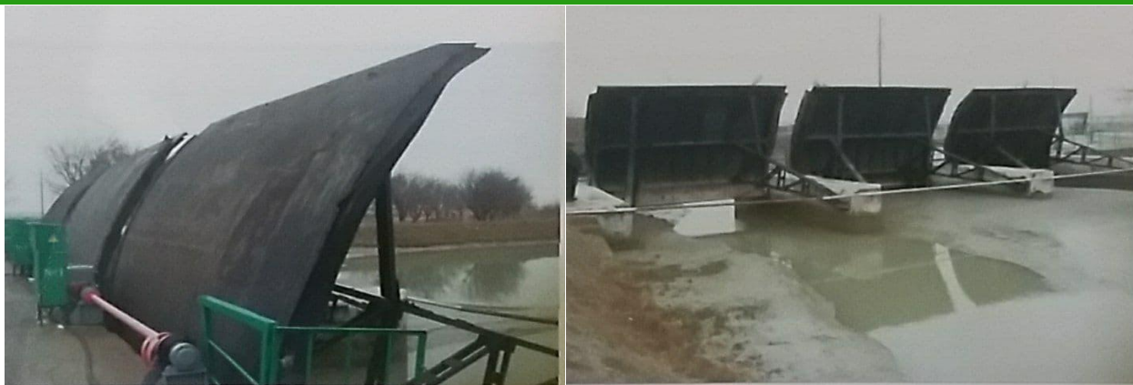
1-расм. Хархўр гидроузелига ўрнатилган сегментли затворлар.
